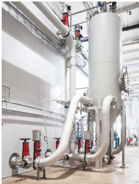
1 Co-Vergärung von Gülle, NAWARO und landwirtschaftlichen Abfällen, Kleinbautzen / 2 Klärschlammfaulung, Brest (Weißrussland) / 3 Nassmechanische Aufbereitung mit Pulper, Madrid (Spanien) / 4 Automatischer Kranbunker Bioabfallvergärung, Helsinki (Finnland) / 5 STRABAG-Vakuum-Entnahmesystem des LARAN® Trockenfermenters, Helsinki (Finnland) / 6 Fermenterbeschickung Bioabfallvergärung, Alphen a. d. Rijn (Niederlande)
