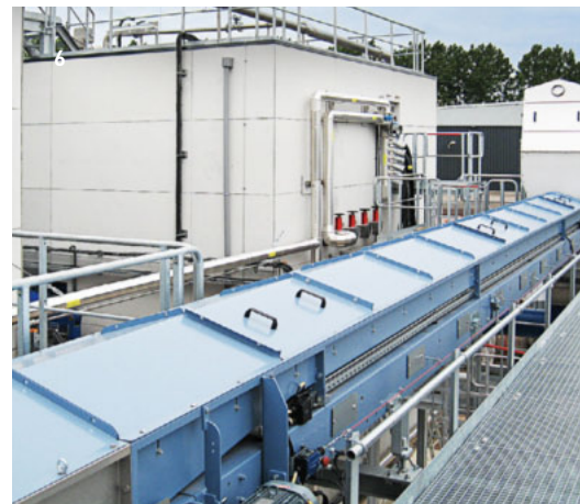
1 Co-Vergärung von Gülle, NAWARO und landwirtschaftlichen Abfällen, Kleinbautzen / 2 Klärschlammfaulung, Brest (Weißrussland) / 3 Nassmechanische Aufbereitung mit Pulper, Madrid (Spanien) / 4 Automatischer Kranbunker Bioabfallvergärung, Helsinki (Finnland) / 5 STRABAG-Vakuum-Entnahmesystem des LARAN® Trockenfermenters, Helsinki (Finnland) / 6 Fermenterbeschickung Bioabfallvergärung, Alphen a. d. Rijn (Niederlande)
